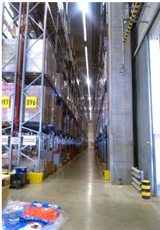
Фиг. 4.11 Снимка на активна зона с включено осветление с нива на осветеност 120\text{ lx} и на неактивна зона с нива на осветеност 20\text{ lx} .
