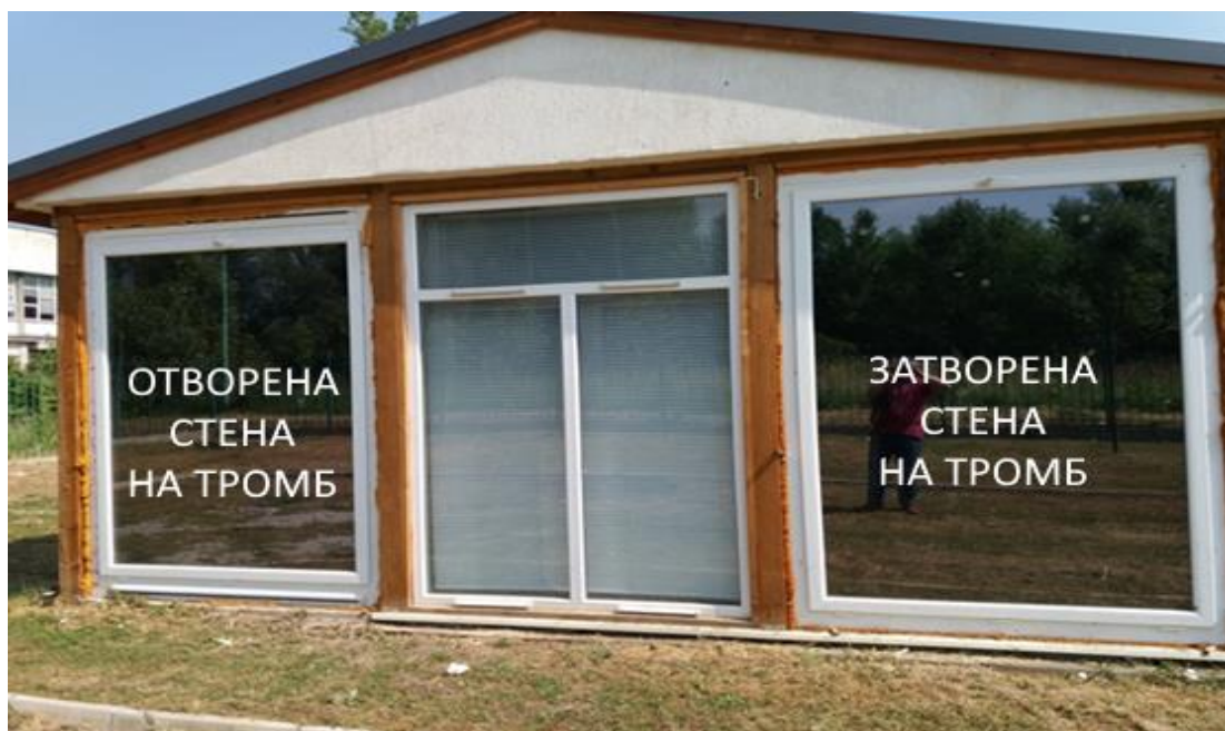
Фиг. 3-8 (3.5.1-4) Модули „затворена стена“ и „отворена стена“ на Тромб
