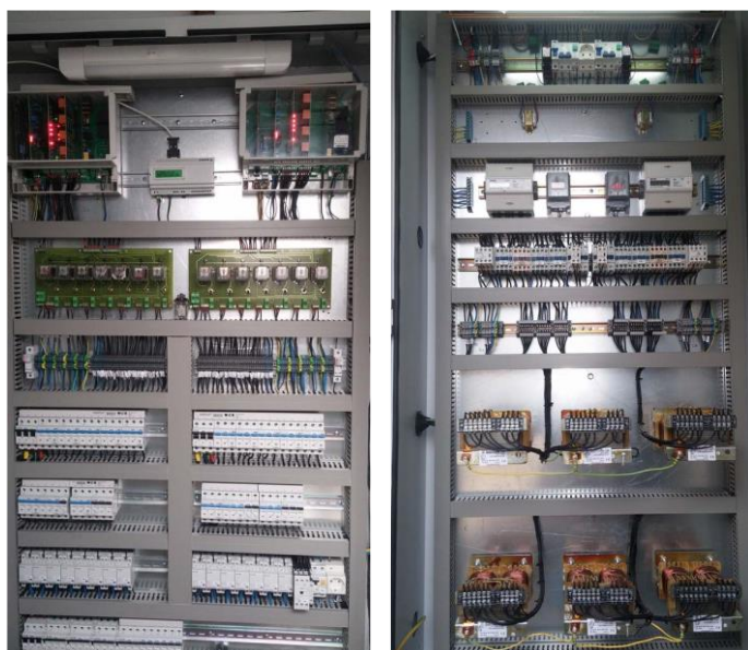
Фиг.5.6 Снимка на лява част на табло НН-контролери, релейни блокове, автоматични прекъсвачи и контактори а), дясна част на табло НН- димиране на нощно дежурно и предпортално осветление б)
