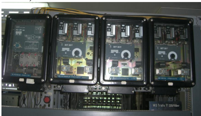
Фигура 5.5.1. Диференциална защита и максималнотокова защита
